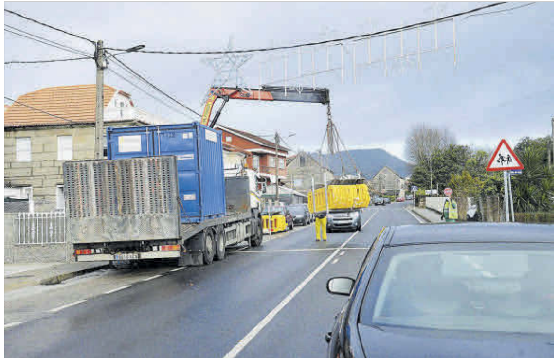
Operarios, esta semana, retirando las vallas tras tapar las zanjas para la tubería en Quintela. // G.N.
