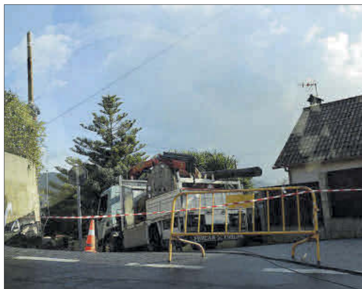
Operarios, retirando los elementos caídos la pasada semana. // G.N.
